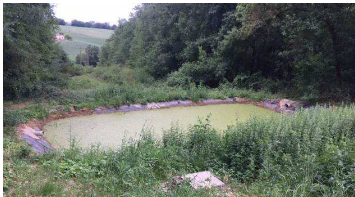
vue de la réserve incendie
