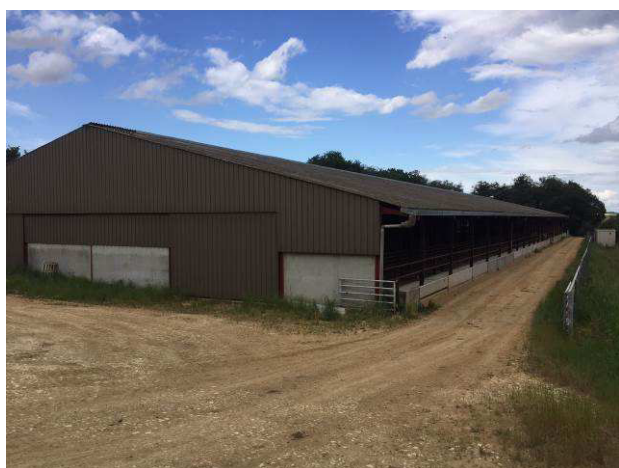
vue de la stabulation et du local administratif
